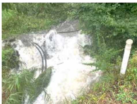
図1. 集中豪雨による取水管流失事故 (2021.8.18)
